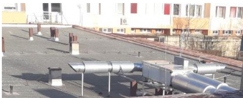
Obr. 14 – Pohled na VZT jednotku – objekt 1 – MŠ ATREA DUPLEX MULTI -N 5000 s vysoce účinným deskovým rekuperátorem a EC motorem
