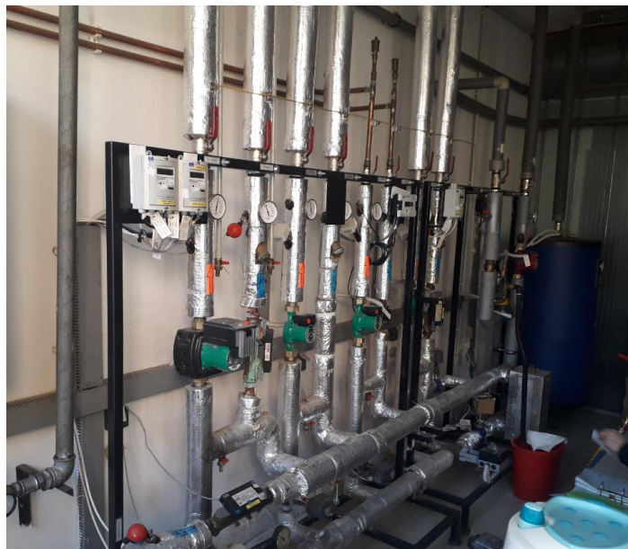
Obr. 9 – Pohled na rozdělovač a sběrač v PS umístěné v objektu 2 – Hospodářská budova
