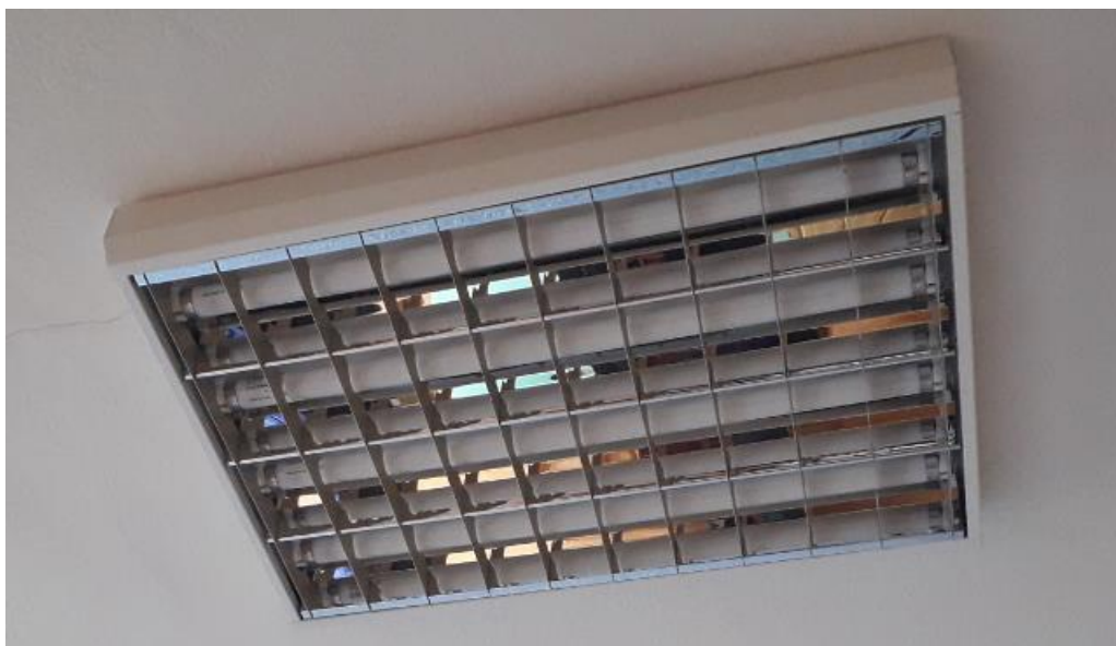
Obr. 17 – Pohled na rozložení osvětlovacích těles a detail typického zářivkového tělesa se 4 trubicemi
