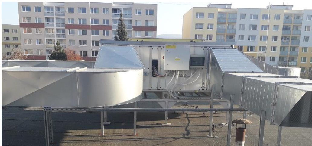
Obr. 14 – Pohled na VZT jednotku – objekt 1 – MŠ ATREA DUPLEX MULTI -N 5000 s vysoce účinným deskovým rekuperátorem a EC motorem
