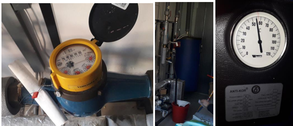
Obr. 13 – Pohled na fakturační měřidlo spotřeby TV (m 3 ) + 200 l zásobník TV s deskovým výměníkem + technické údaje zásobníku teploty 55 °C
