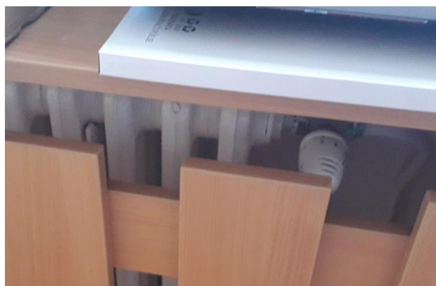
Obr. 11 – Pohled na stávající otopná tělesa článková litinová s TRV
