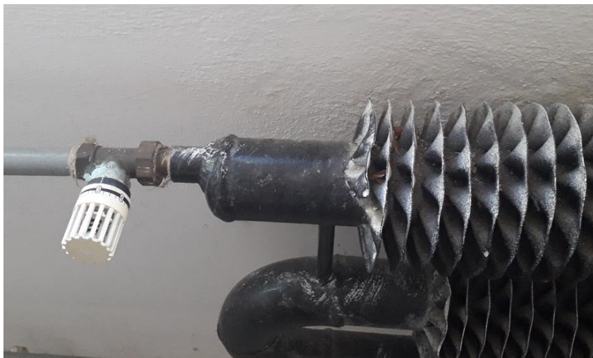
Obr. 12 – Pohled na stávající ocelový registr - otopné těleso s TRV – sušárna v PS hospodářský pavilon
