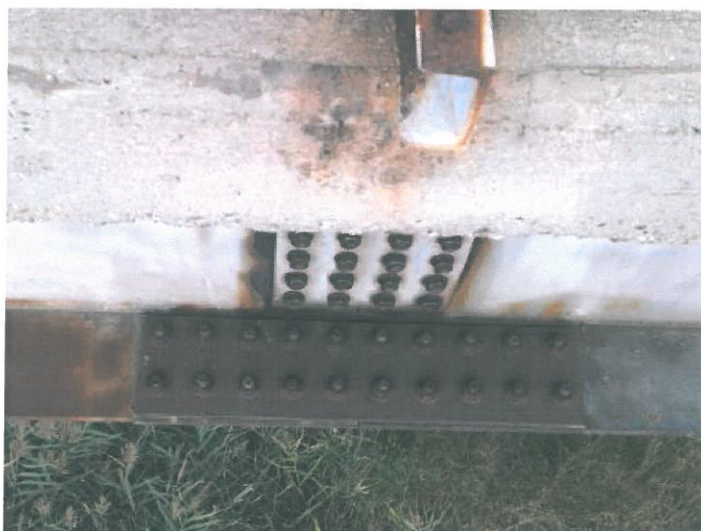
Koroze šroubového styku hlavního nosníku.
