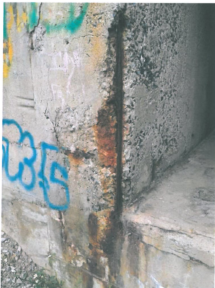
Degradace opěry OP1 s korozí výztuže závěrné zídky
