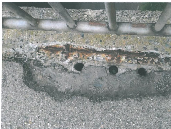
Dodatečné odvodnění lávky
