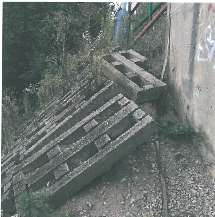
Poničení zpevnění svahu u opěry OP1.
