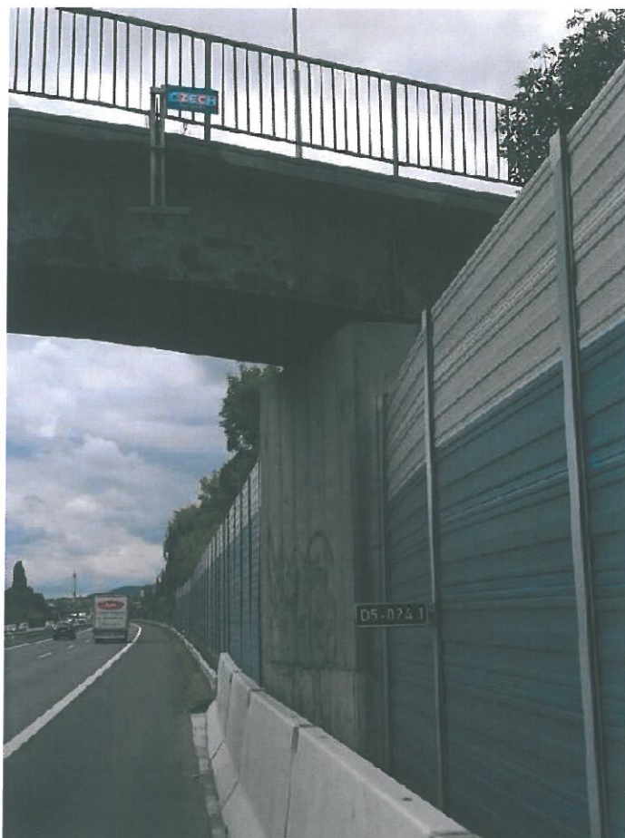
Pilíř P2 pohled od Prahy - zasazení pilíře do PHS - koroze ocelové nosné konstrukce
