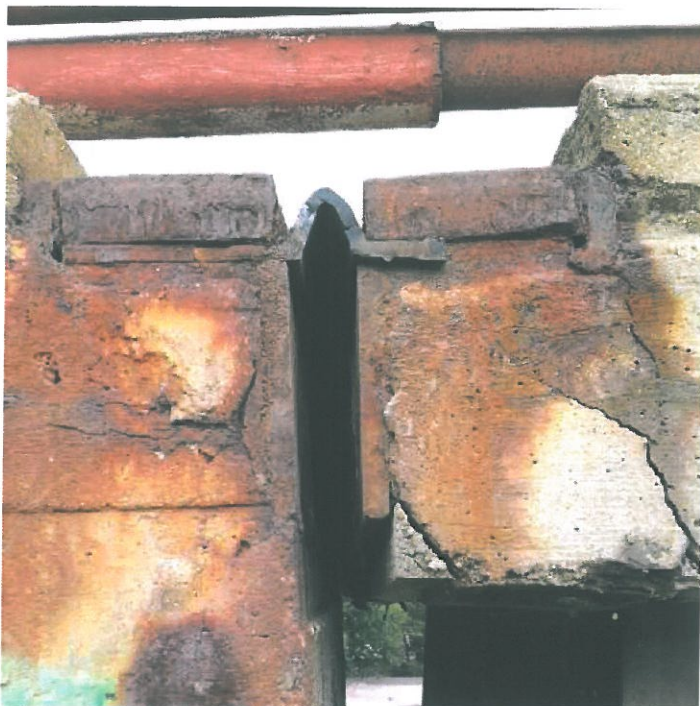
Mostní závěr na opěr OP1 - koroze ocelových profilů.
