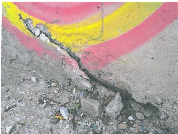
Silná degradace paty pilíře P3
