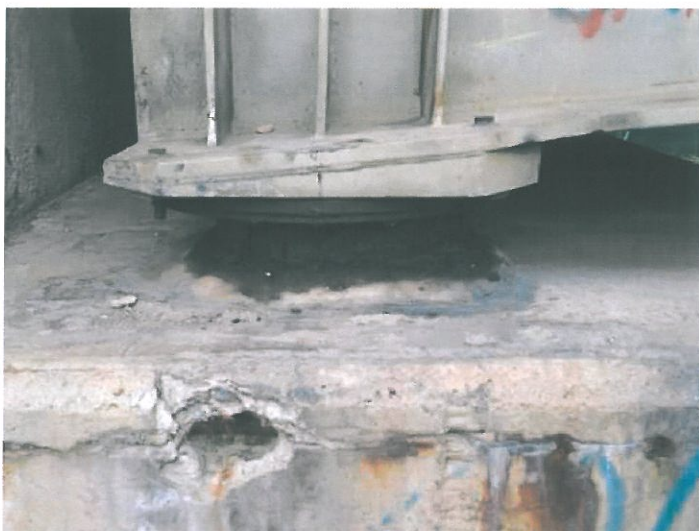
Hrcové ložisko na opěře OP1, degradace úložného prahu.
