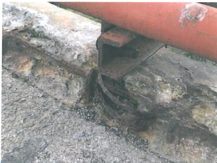
Silná degradace řimsy - místo kotvení sloupku zábradlí.
