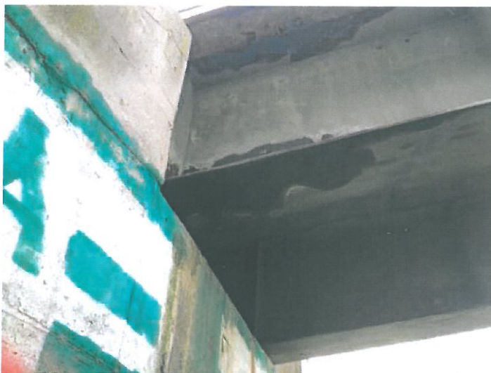
Koroze ocelové konstrukce na opěře OP4.
