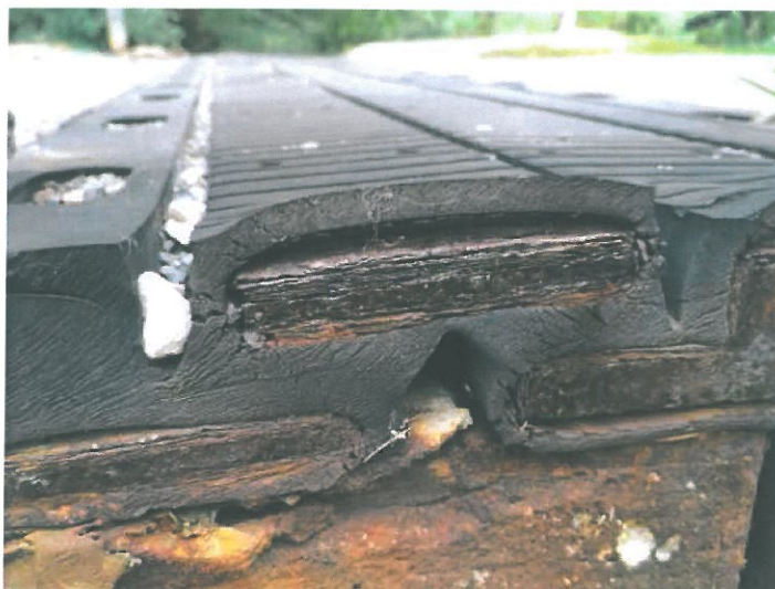
Silná koroze ocelových prvků kobercového závěru na opěře OP4.
