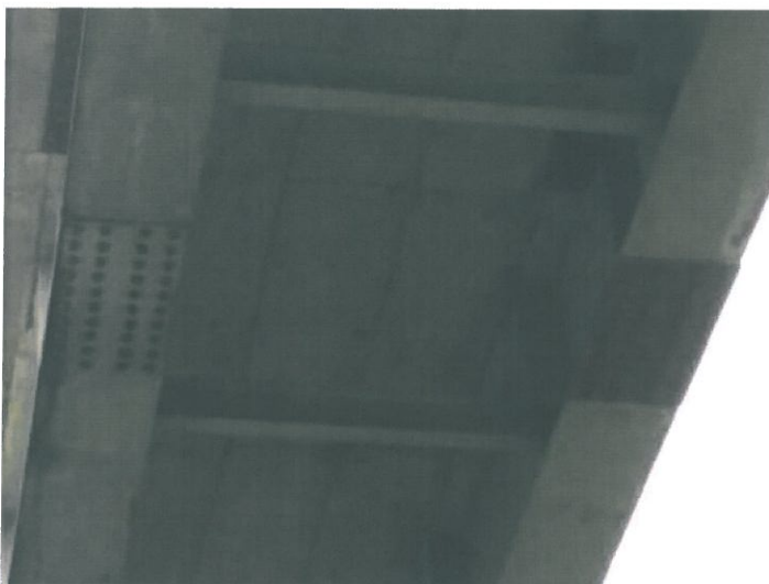
Koroze šroubového styku hlavního nosníku.
