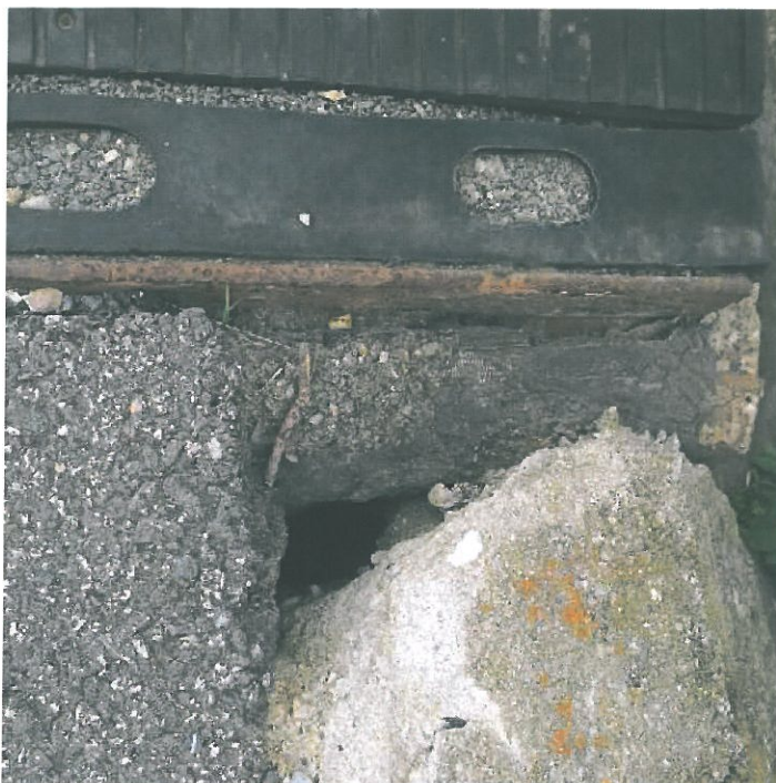
Odtržení mostního závěru od konstrukce - opěra OP4.
