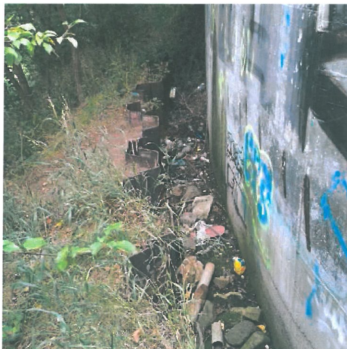
Jímka ze štětovnice kolem opěry OP4
