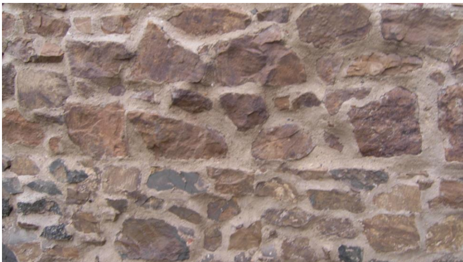
Pohled na styl zdění hradebních zdí. Použití nepravidelných různě velikých kamenů stejných kvalit.
