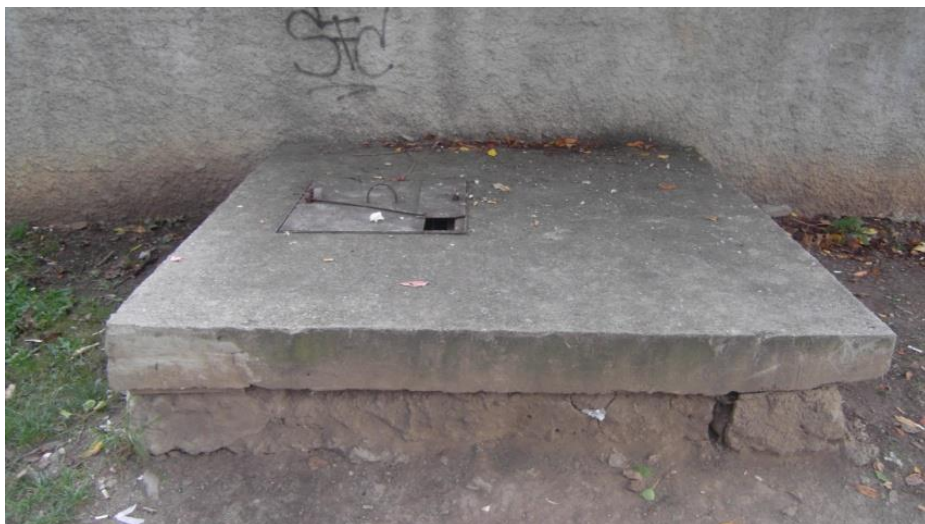
Pohled na stávající studni zakrytou betonovou deskou
