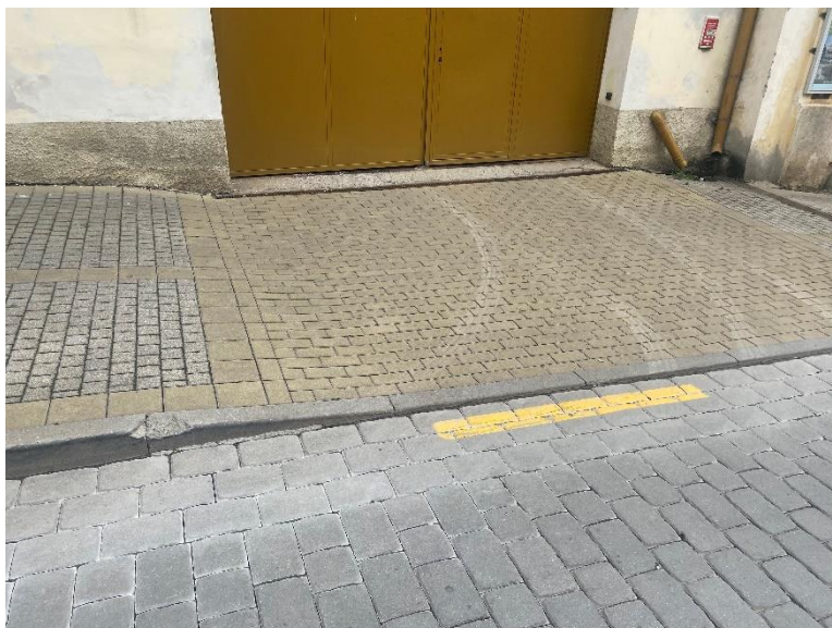
Foto 2: Lokální výměna poškozených obrubníků
