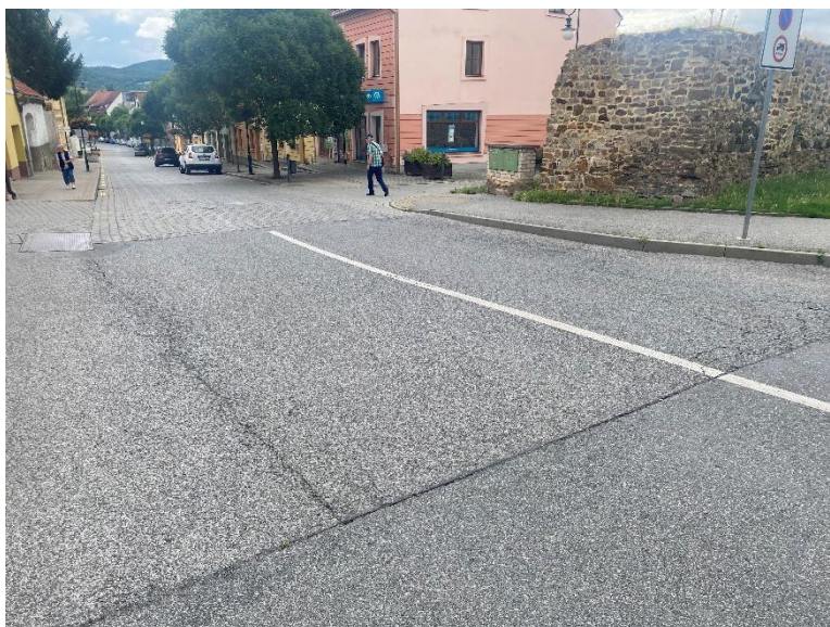
Foto 1: Začátek opravy – napojení na stávající vozovku ze živice
