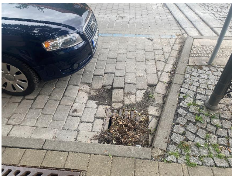
Foto 6: Lokální výměna celé konstrukce kolem stávající UV
