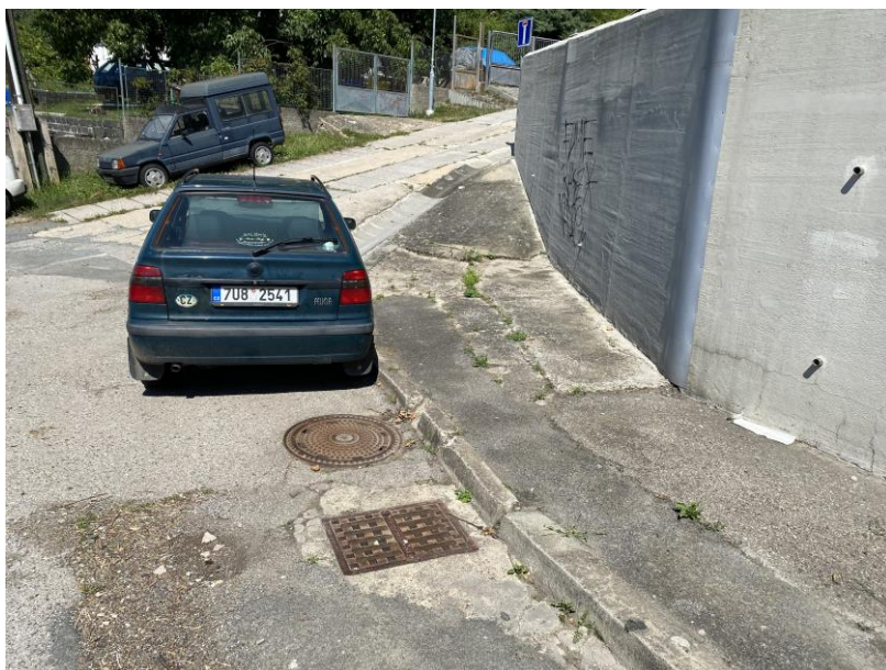
obr.8 –vozovka z panelů, odvodňovací žlaby
