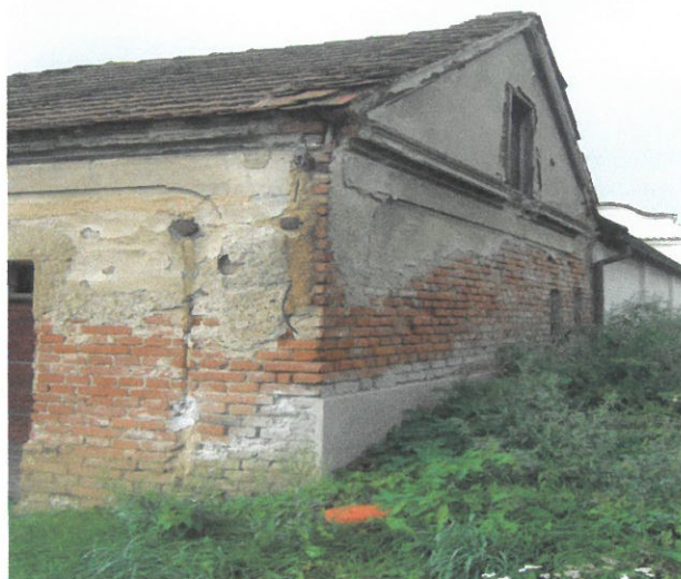
S výstavbou kolumbária byla spojena sanace ohradní zdi spolu severní zdi objektu márnice
