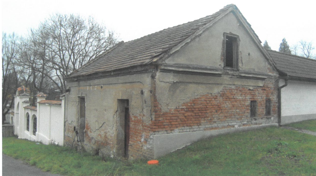
Pohled ze severní strany na současný stav nárožního objektu bývalé márnice. Zprava na objekt navazuje nově postavené Kolumbárium. Opravená východní vstupní ohradní zeď přímo navazuje na objekt bývalé márnice.
