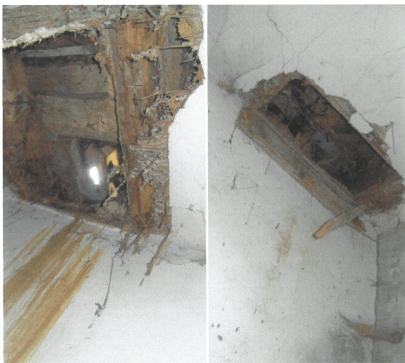
Sonda do stropní konstrukce již byla v minulosti provedena
