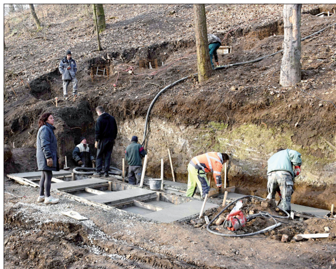
■ V únoru začala stavební firma betonovat patky k plánované skluzavce na Městské hoře.
